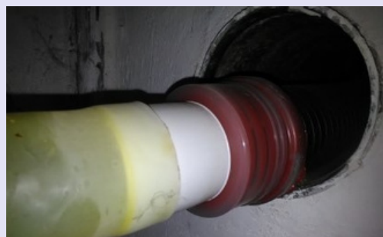
Nač typizované dílce - stačí udělat hrdlo a koncentrická redukce také nepatří vodorovně
