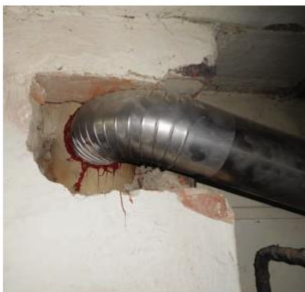
Provedení sopouchu při dodatečném vložkování – nedbalost zhotovitele – vystavena kladná revizní zpráva, kominík neshledal závadu.
