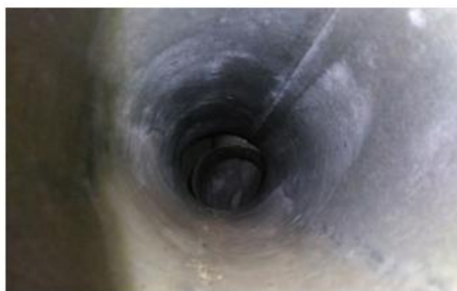
Provedení sopouchu při dodatečném vložkování – nedbalost zhotovitele – vystavena kladná revizní zpráva, kominík neshledal závadu.
