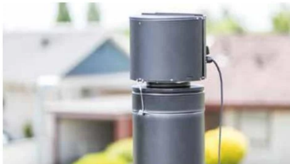
Realizace Draftboosteru na nerezový komín
