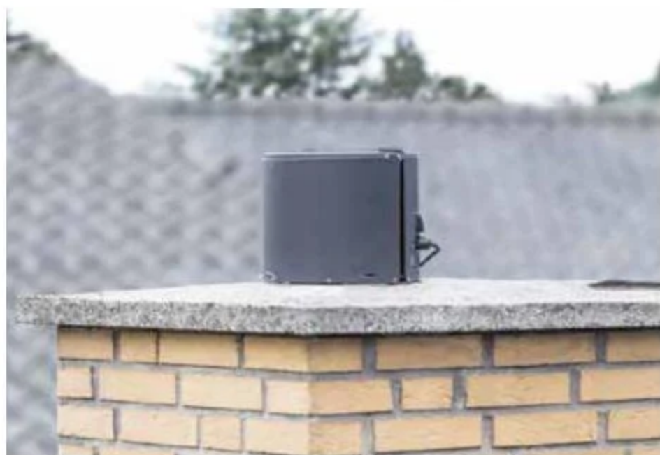
Realizace Draftboosteru na zděný komín
