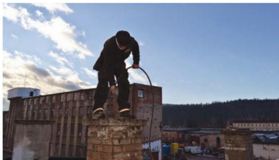
Vyčištění komínu ohebnou hřídelí
