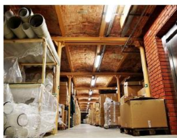
Obr. 4 Skladové prostory Želešice
