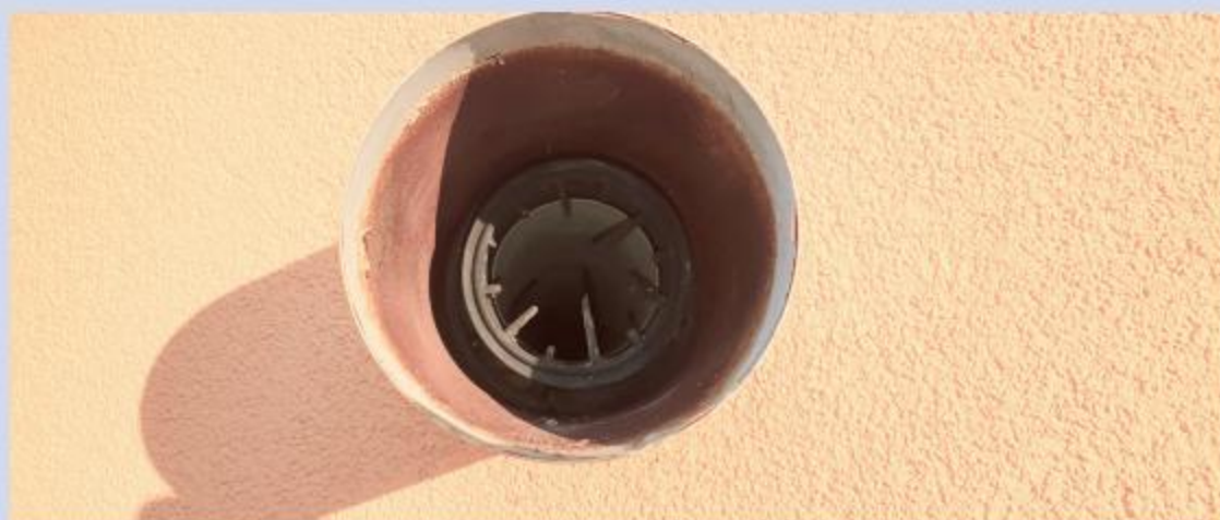
turbo přes fasádu, vnitřní kratší
