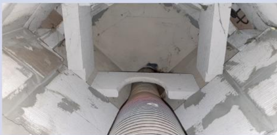
obestavěná vložka z ytongu
