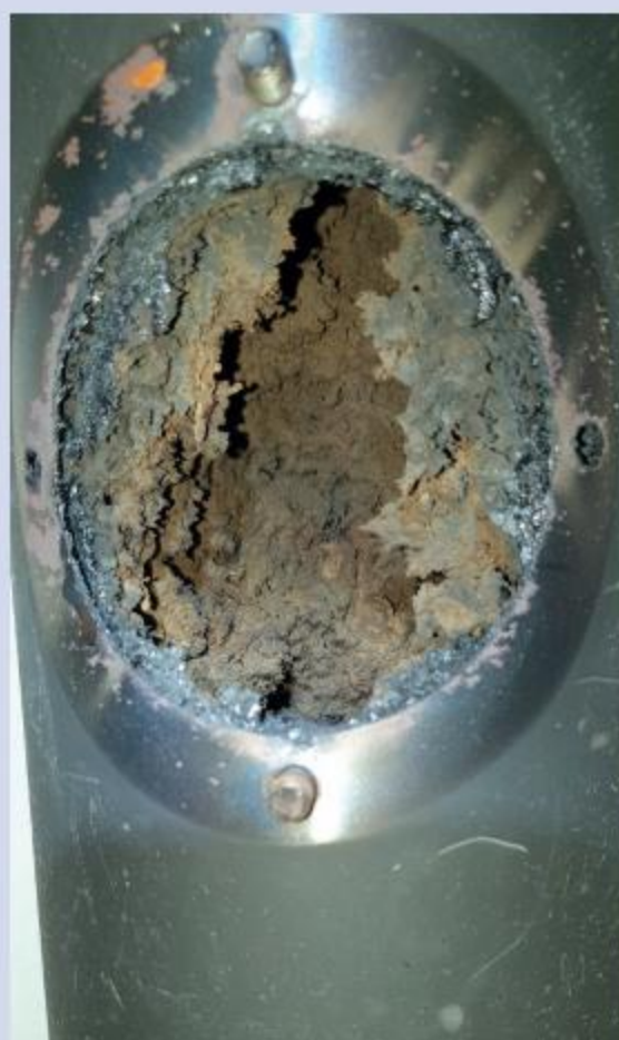
ucpaný kouřovod (2)
